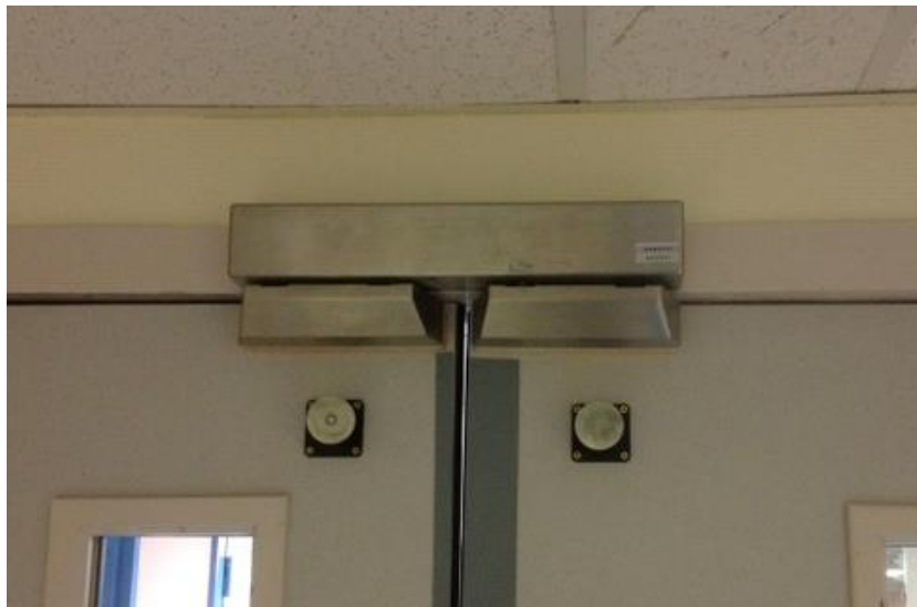
Figure n° 11 - Vue d'un verrou motorisé à pitons pour portes en va-et-vient
